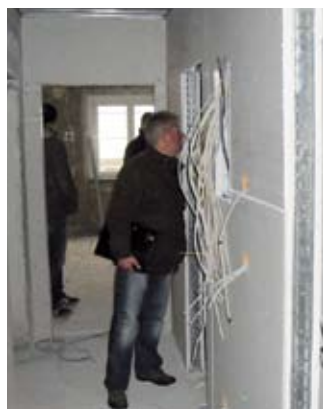
Einbau der neuen Installation für Elektro, Heizung und Sanitär, eine Grundvoraussetzung für eine hochwertige technische Wohnungsausstattung.
