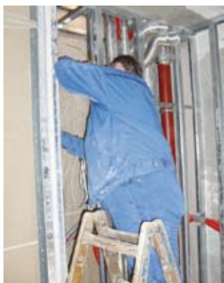
Einbau der neuen Installation für Elektro, Heizung und Sanitär, eine Grundvoraussetzung für eine hochwertige technische Wohnungsausstattung.
