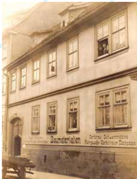
Dieses Foto des Hauses Siebleber Straße 26 entstand vor einem Jahrhundert. Damals verkaufte hier Max Grothe Baumaterialien. Fotos (2): Archiv Altstadtverein
