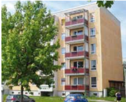
Hausansicht mit den neuen Balkonen
