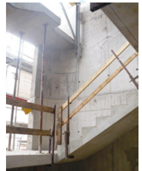
Treppenauge mit Fahrstuhlschacht
