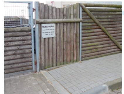
Abgesenkter Bordstein am Mülltonnenstandplatz
