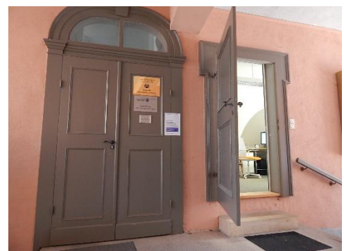
Zugang von der Toreinfahrt aus (rechte Tür)
